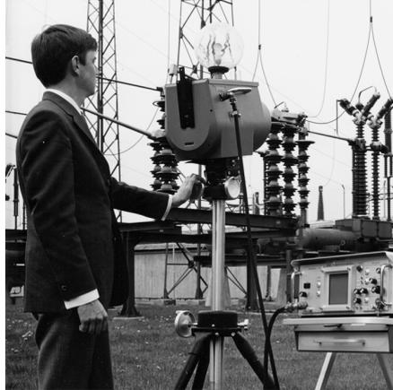
**Abbildung 19.2** 1969: Modell 661 der Thermovision. Die Kamera wog ca. 25 kg, das Oszilloskop 20 kg und das Stativ 15 kg. Für den Betrieb wurden darüber hinaus ein 220-Volt-Generator und ein 10-Liter-Gefäß mit flüssigem Stickstoff benötigt. Links neben dem Oszilloskop ist der Polaroid-Aufsatz (6 kg) zu erkennen.
